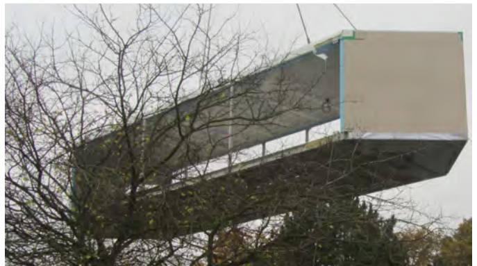
Anlieferung der Bauelemente für das neue Haus Ruhrblick, 2012
