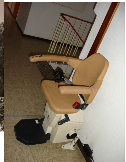
Treppenlift im alten Haus Ruhrblick
